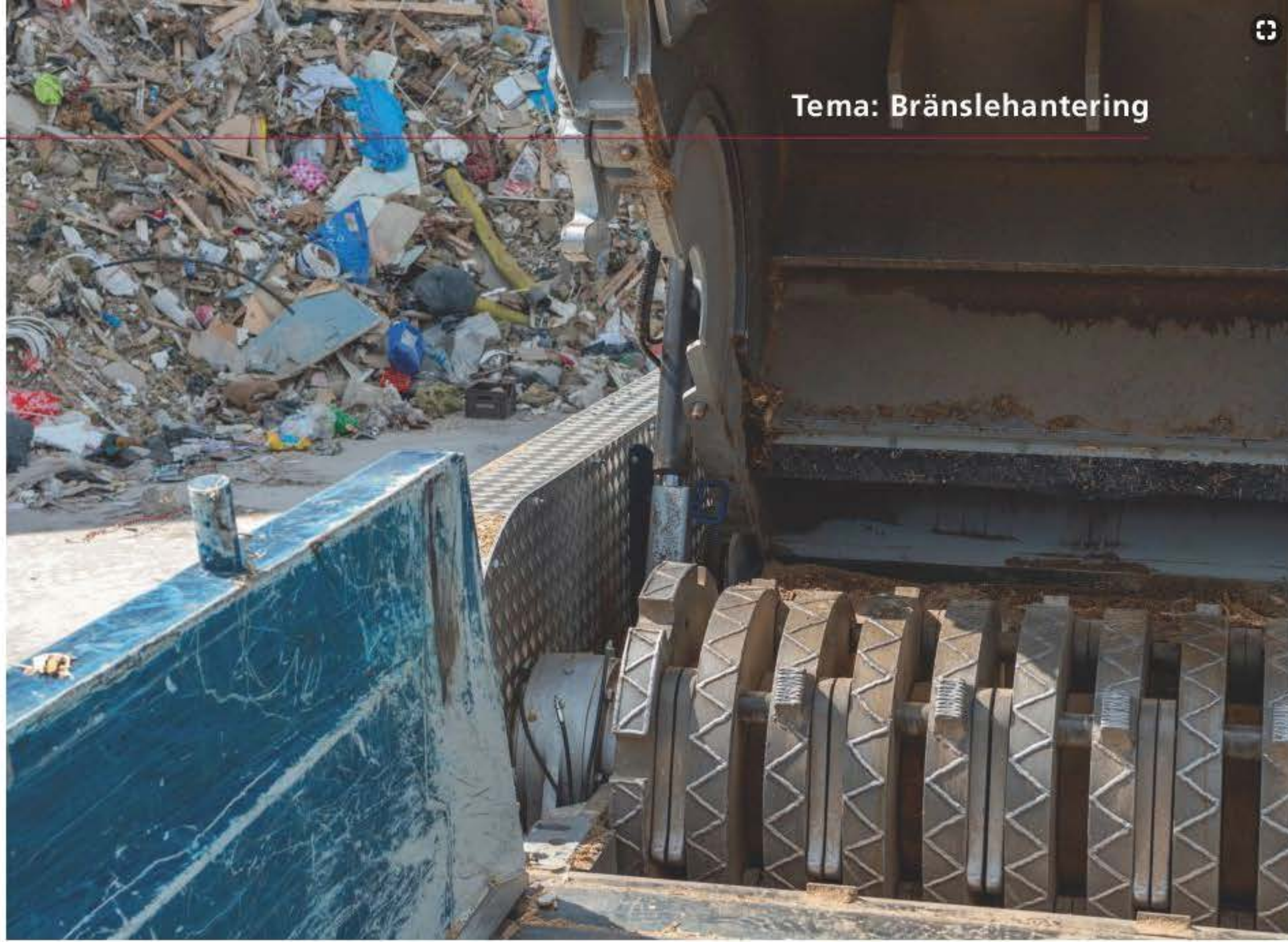
Krossen slår sönder trä samt metallmaterial som avskiljs med en magnet efter krossen.
